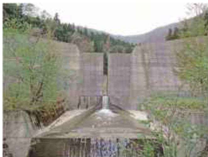
写真 3.34 ⑫ 滝沢川 滝沢 コンクリートスリット堰堤 (長野県) 規模：高さ 14.0m、堰堤長 137.0m (長野県治水砂防協会姫川支部, 2017)
