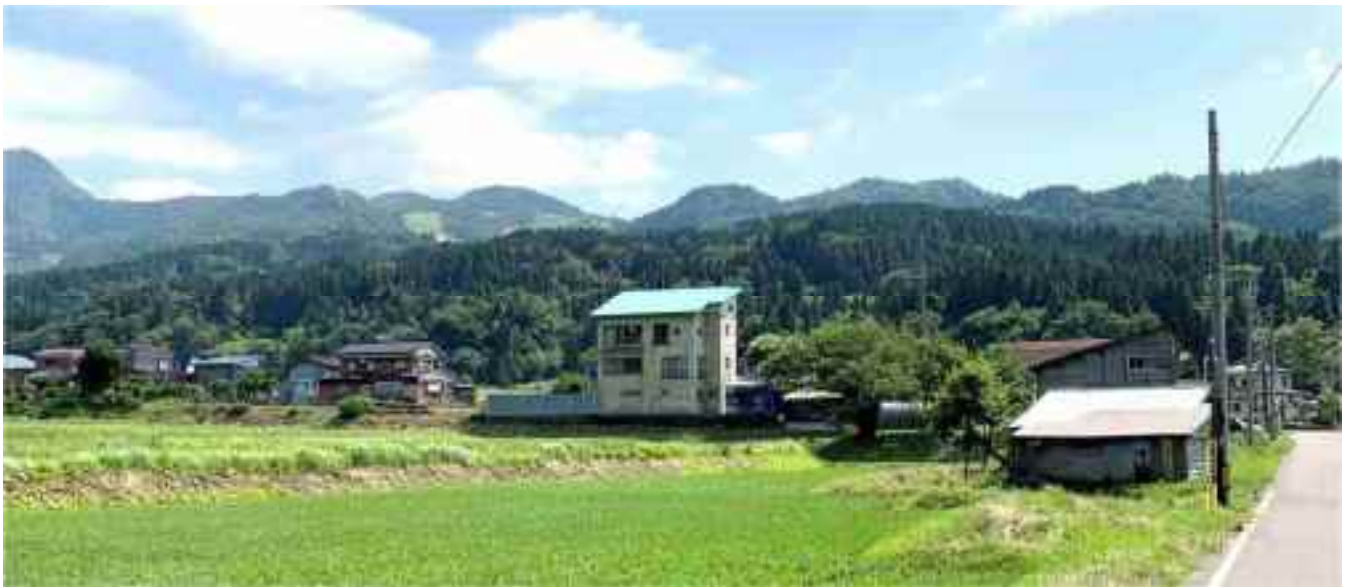
写真 2.1 蒲池の地すべり地全景（三宮橋より），2020 年撮影
