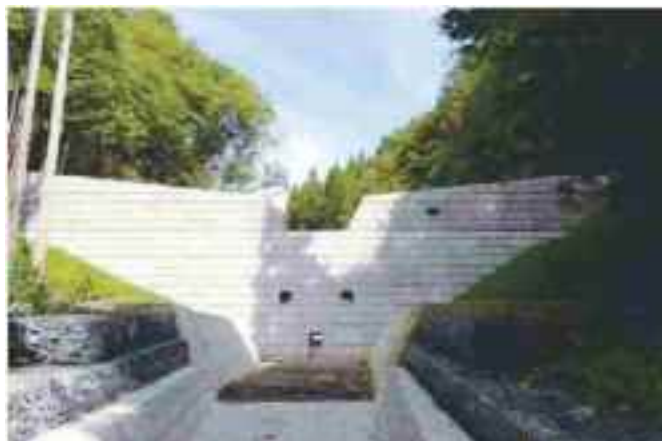
写真 3.27 ⑤ 西東原沢 野平 二重擁壁砂防堰堤（長野県） 規模：高さ 8.0m、堰堤長 48.5m （長野県治水砂防協会姫川支部，2017）
