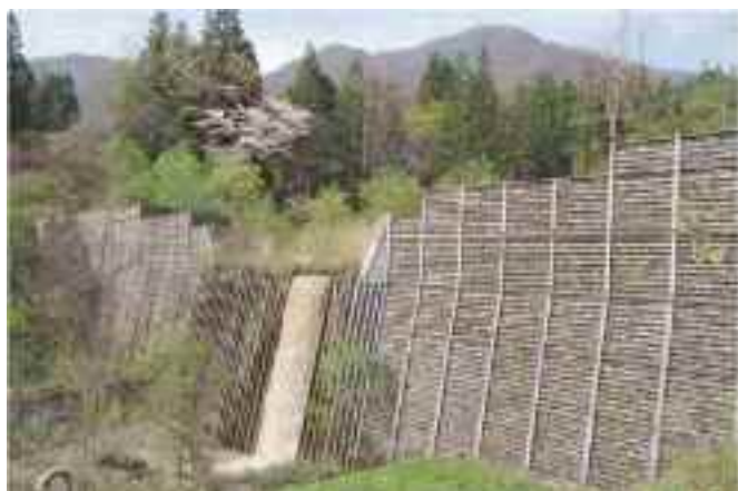
写真 3.11 ② 濁沢 李平 鋼製杵堰堤（長野県） 規模：高さ 14.0m、堰堤長 91.0m （長野県治水砂防協会姫川支部，2017）
