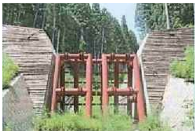
写真 3.33 ⑪ 海道沢 堀之内 2号堰堤 (長野県) 規模：高さ 8.0m、堰堤長 36.0m (長野県治水砂防協会姫川支部, 2017)
