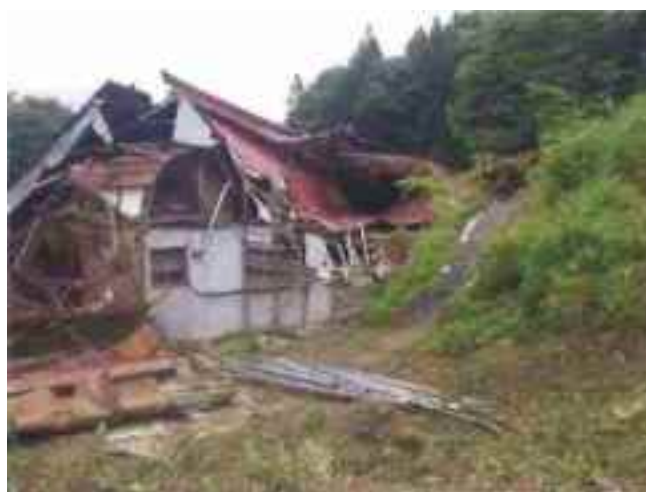
写真 2.55 土砂によって潰された民家 （地盤工学会・土木学会地盤工学委員会，2014）
