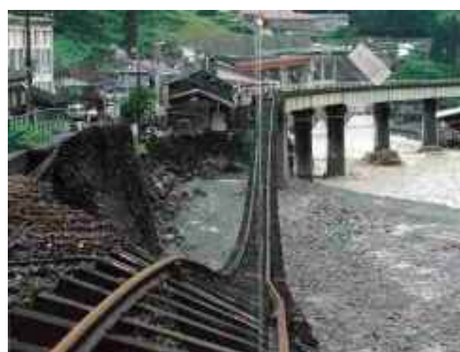
写真 2.44 橋脚を流された JR 大糸線 (糸魚川市, 1995)
