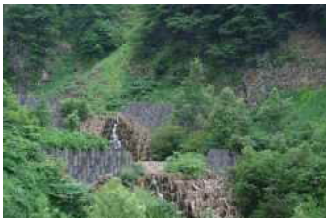
写真 3.10 ① 中股川第2号砂防堰堤（長野県） 規模：高さ 12.6m、堰堤長 57.1m (2018 年撮影)
