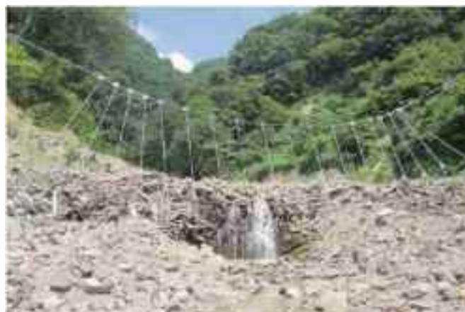
写真 3.12 ③ 濁沢 深原 ワイヤネット式堰堤（長野県） 規模：高さ 3.0m、長さ 28.9m （長野県治水砂防協会姫川支部，2017）
