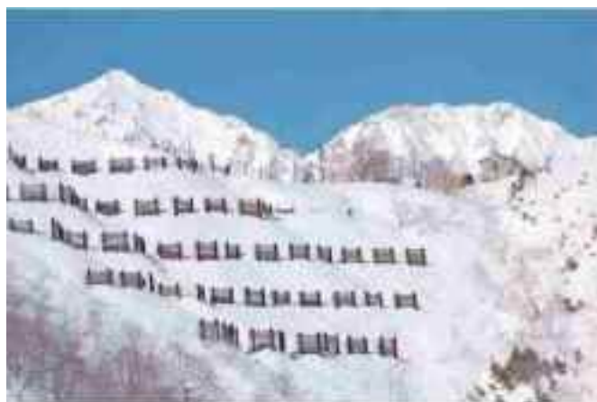
写真 3.29 ⑦ 八方尾根 黒菱 雪崩予防柵（長野県） 規模：高さ 4~6m、長さ 520.0m （長野県治水砂防協会姫川支部，2017）
