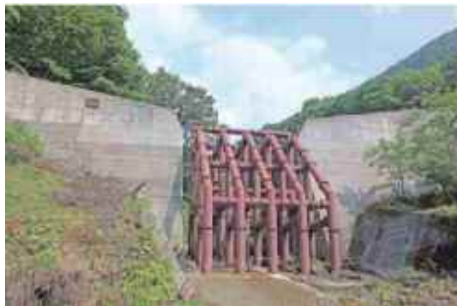
写真 3.16 ⑧ 黒川沢 里見 鋼製フレーム構造堰堤（長野県） 規模：高さ 15.5m、堤頂長 70.7m (長野県治水砂防協会姫川支部, 2017)
