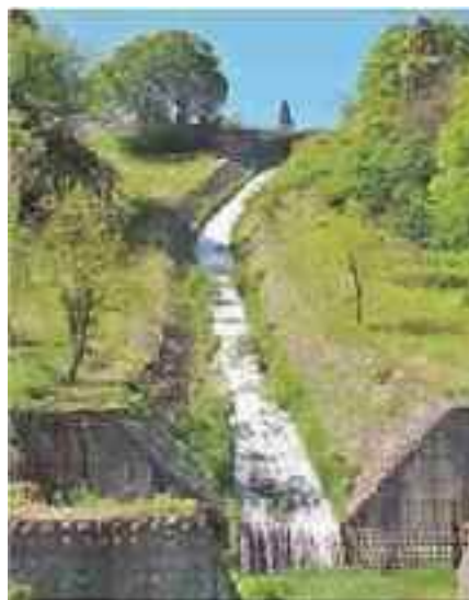
写真 3.20 ⑩ 日かげ沢 塩水 高落差流路工（長野県） 流路長：130.0m （長野県治水砂防協会姫川支部，2017）
