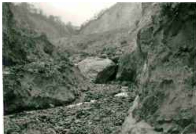
写真 3.17 ⑦ 金山沢 小谷村 着工前の金山沢第1号砂防堰堤（松本砂防事務所） (1973 年撮影)
