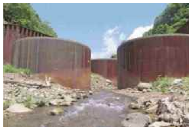
写真 3.14 ⑤ 土谷川 奉納 セル堰堤（長野県） 規模：高さ 10.0m、堰堤長 78.8m （長野県治水砂防協会姫川支部，2017）
