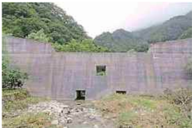
写真 3.31 ⑨ 犬川 大日向 砂防堰堤 (長野県) 規模：高さ 14.0m、堰堤長 182.0m (長野県治水砂防協会姫川支部, 2017)
