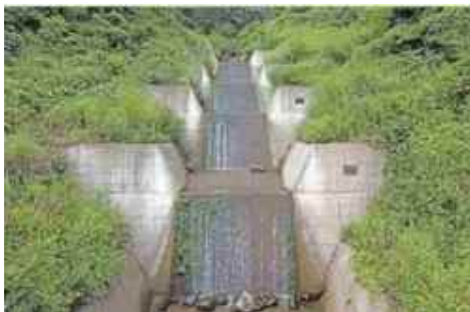
写真 3.19 ⑨ 日かげ沢 大別当 階段状床固工群（長野県） 規模：高さ 4.0～5.0m、落差 2.3～4.1m （長野県治水砂防協会姫川支部，2017）
