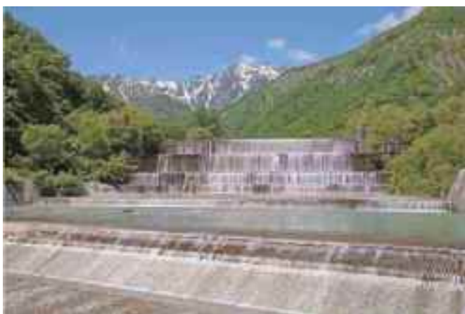
写真 3.30 ⑧ 平川 北城 源太郎砂防堰堤（松本砂防事務所） 規模：高さ 8.0m、堰堤長 231.0m （長野県治水砂防協会姫川支部，2017）
