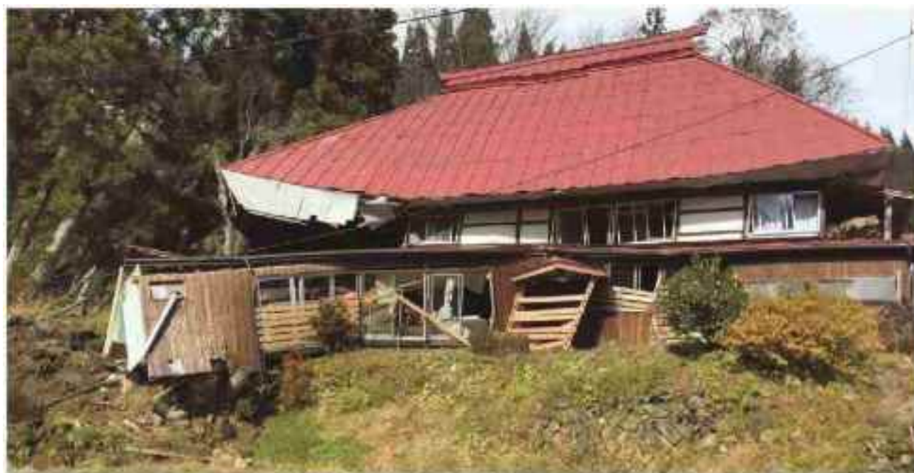
写真 2.56 建物に達した崩落土砂
