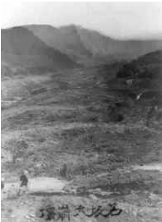
写真 2.15 松ヶ峯から浦川の土砂堆積・稗田山崩れを望む （小谷村役場蔵）
