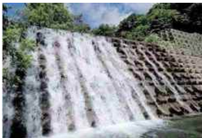
写真 3.22 ⑫ 西親沢 千国 コンクリートブロック堰堤（長野県） 規模：高さ 8.3m、堰堤長 86.7m （長野県治水砂防協会姫川支部，2017）
