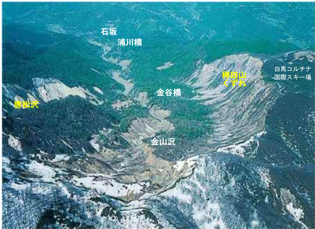
写真 2.31 稗田山源頭部上空から浦川下流を望む (国土交通省松本砂防事務所撮影)
