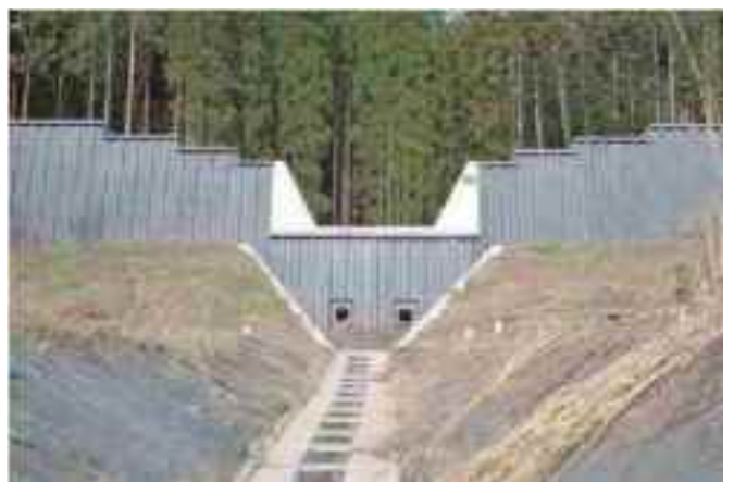
写真 3.26 ④ 沢尻沢 野平 二重擁壁砂防堰堤（長野県） 規模：高さ 6.5m、堰堤長 75.0m (長野県治水砂防協会姫川支部，2017)
