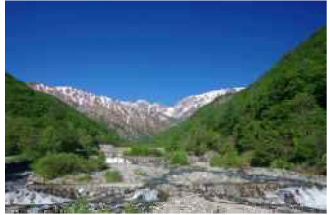
写真 3.24 ② 南股入川・松川 北城 二股砂防堰堤と松川流路工（松本砂防事務所） 二股砂防堰堤 規模：高さ 14.0m、堤頂長 175.0m 松川流路工 延長：4,550m、流路工幅：100m (2019 年撮影)
