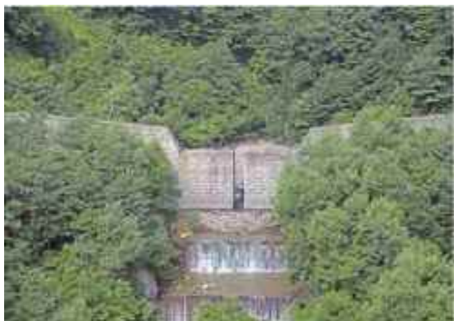
写真 3.21 ⑪ 西親沢 若栗 コンクリートスリット堰堤（長野県） 規模：高さ 10.0m、堰堤長 95.0m （長野県治水砂防協会姫川支部，2017）
