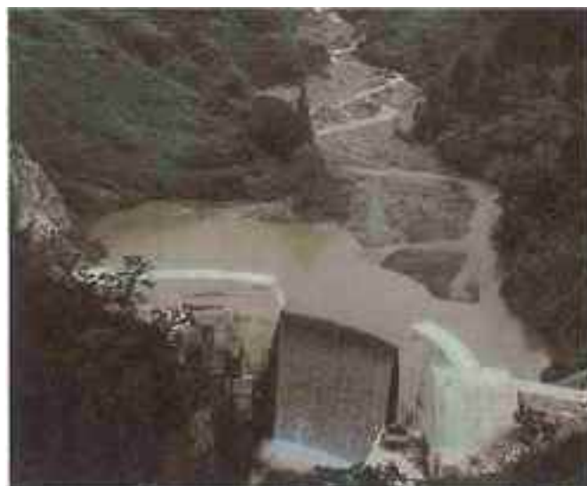
写真 3.8 ② 根知川 糸魚川市 根知川砂防堰堤（新潟県） 規模：高さ 24.0m、長さ 56.6m (新潟県土木部砂防課, 1993)
