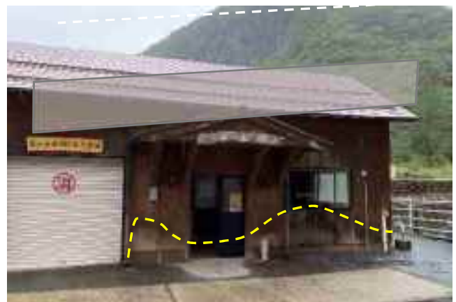
写真 2.50 今も土砂堆積の痕跡（黄破線が土砂の堆積上面）が残る中土駅, 2019 年撮影
