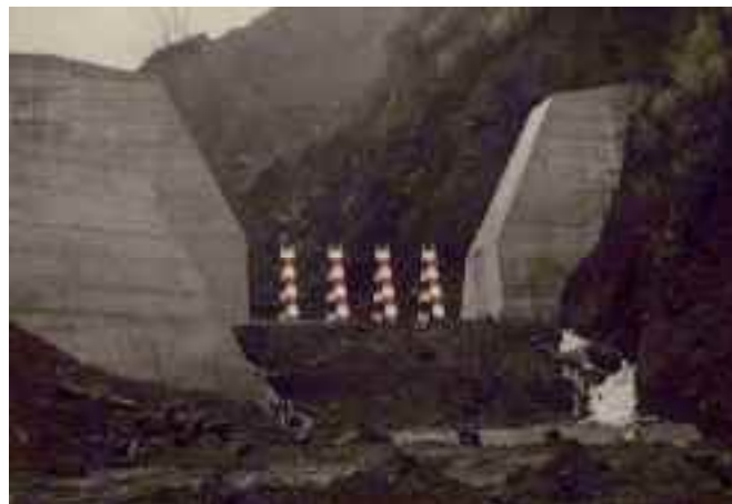
写真 3.18 ⑦ 金山沢 小谷村 完成後の金山沢第1号砂防堰堤（松本砂防事務所） 規模：高さ 10.0m、堤頂長 49.0m (1973 年撮影)
