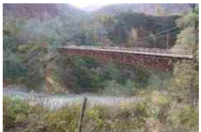
写真 2.33 金谷橋と浦川，2019 年撮影
