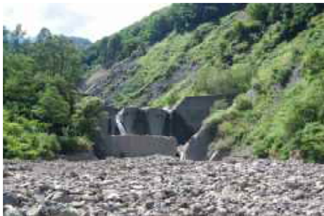
写真 3.15 ⑥ 浦川 小谷村 浦川砂防堰堤（松本砂防事務所） 規模：高さ 21.0m、堤頂長 147.0m (2018 年撮影)
