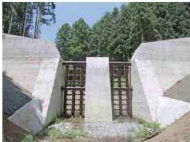
写真 3.32 ⑩ 海道沢 堀之内 3号堰堤 (長野県) 規模：高さ 10.0m、堰堤長 53.0m (長野県治水砂防協会姫川支部, 2017)
