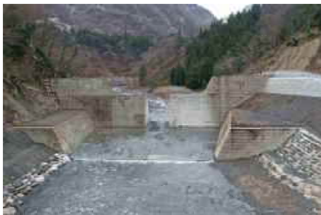
写真 3.7 ① 小滝川 小滝 小滝瀬野田砂防堰堤（新潟県） 規模：高さ 14.5m、堰堤長 83m (2019 年撮影)
