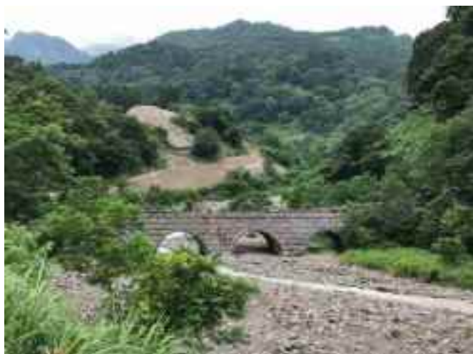
写真 3.13 ④ 浦川 石坂 浦川スーパー暗渠砂防堰堤（松本砂防事務所） 規模：高さ 11.0m、堤頂長 120.4m、暗渠径 8.0m （2019 年撮影）
