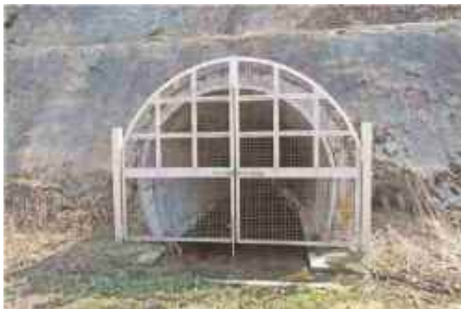
写真 3.25 ③ 倉下地すべり 排水トンネル（長野県） 規模：高さ 3.05～3.07m、長さ 570.0m (長野県治水砂防協会姫川支部，2017)
