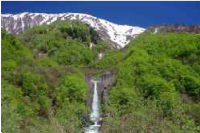
写真 3.23 ① 松川 北城 北股上流砂防堰堤（松本砂防事務所） 規模：高さ 38.0m、堰堤長 56.0m (2019 年撮影)
