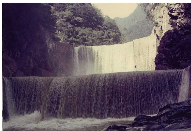
山の神砂防堰堤(昭和50年9月)
