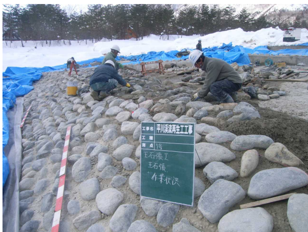
玉石張り工 作業状況
