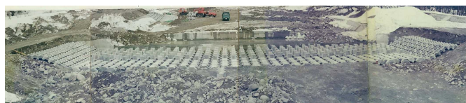
護床工（ブロック据付完了）
