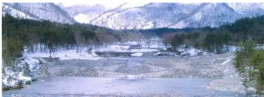
完 成（第8号床固工 魚道）
