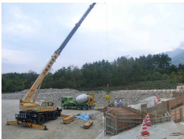
コンクリート打設状況
