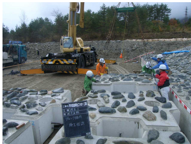
魚道ブロック据付状況
