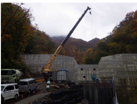
コンクリート打設状況 (クレーンによるバケット打設)
