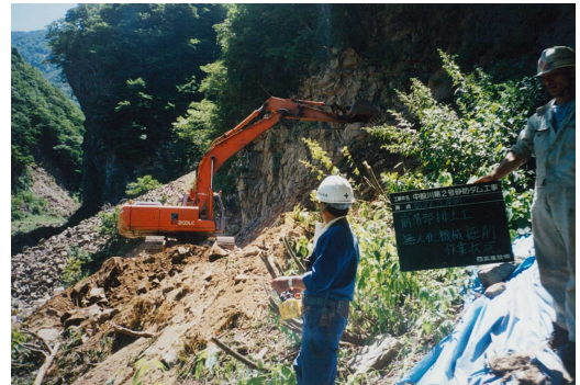
無人化施工機械による崩落部の掘削
