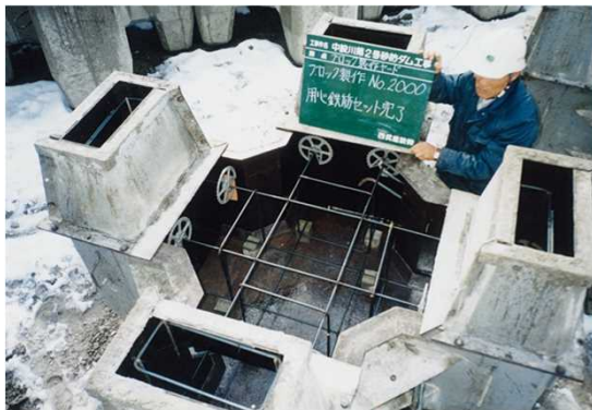
重力式ブロックの型枠・鉄筋 組立完了
