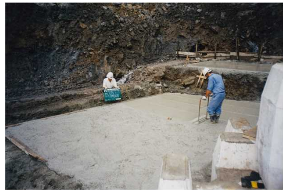
堰堤基礎部の均しコンクリート打設
