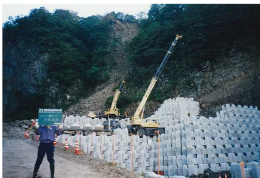
重力式ブロックの据付、堰堤築造
