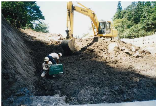
堰堤の掘削状況
