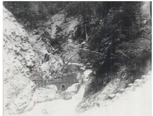
コンクリート打設状況
