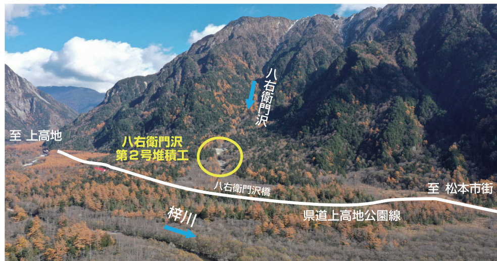
八右衛門沢第2号堆積工と県道上高地公園線
