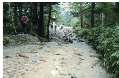
豪雨により県道が土石流によって寸断され、観光客が孤立。(昭和54年)
