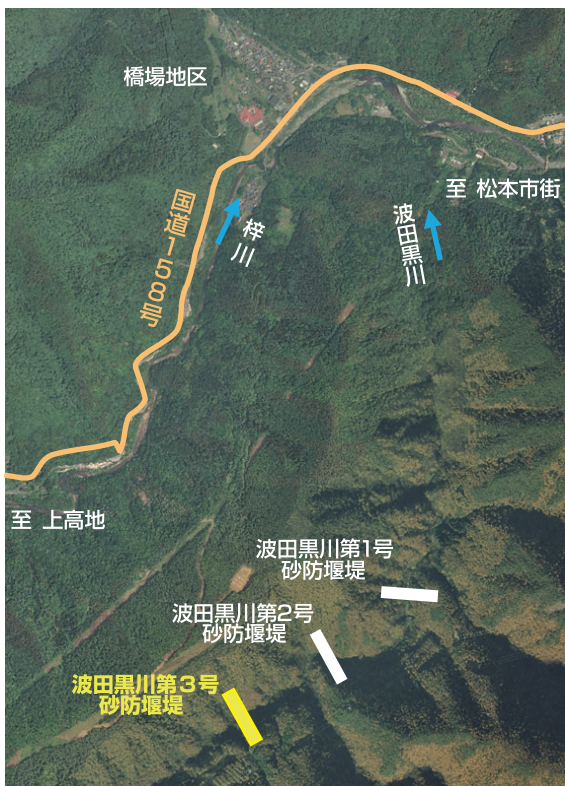
波田黒川第3号砂防堰堤と橋場地区
