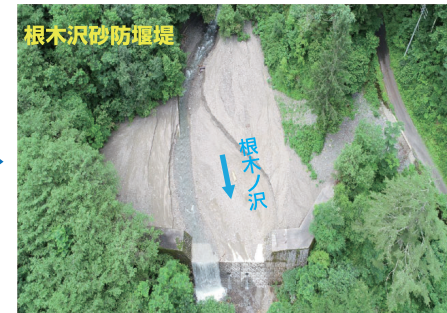
被災後 令和2年7月
