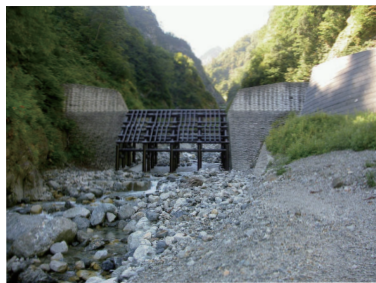
南股第4号砂防堰堤
