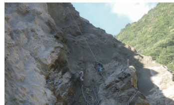
モルタル吹付状況
