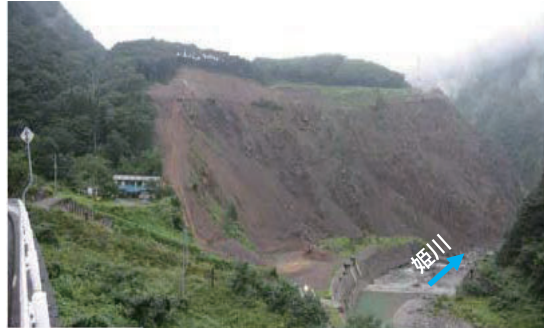
着工前 平成19年9月
