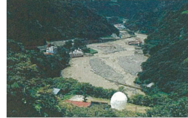
被災直後 平成7年7月13日
