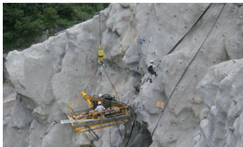
ロックボルト削孔状況
