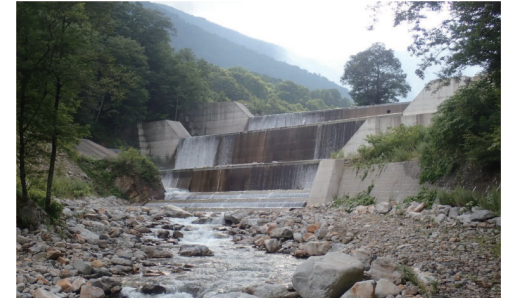
箆川第1号砂防堰堤
