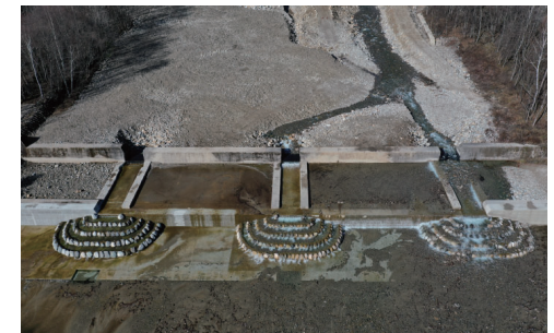
箆川第2号床固工(魚道の設置)
