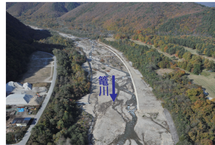
完成した床固工群(上流部)
