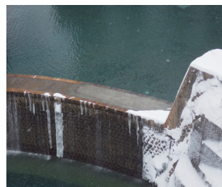
H25年度 第一副堤天端 補修後
