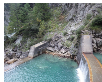
H28年度 第一副堰堤右岸下流(側壁工) 補修前
