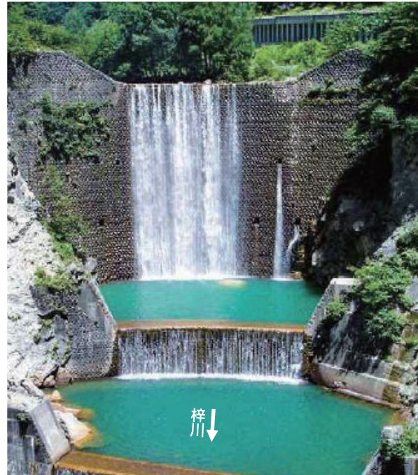
現在の釜ヶ淵砂防堰堤
