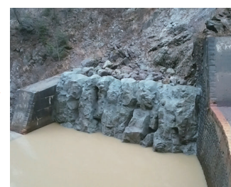
H28年度 第一副堰堤右岸下流(側壁工) 補修後
