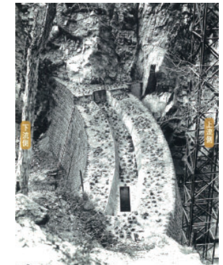
堰堤内部に玉石を埋め込んだコンクリート
