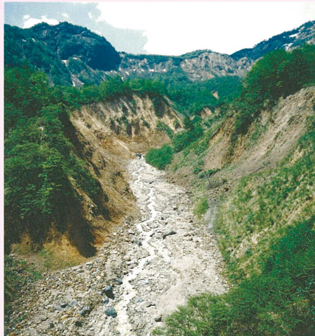
●浦川上流の荒廃状況
