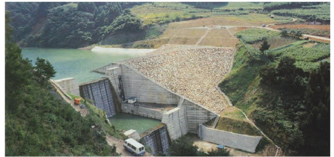
写真 5.14 ② 月沢 松本市保福寺町 月沢砂防堰堤（長野県） （長野県砂防課，2022）
