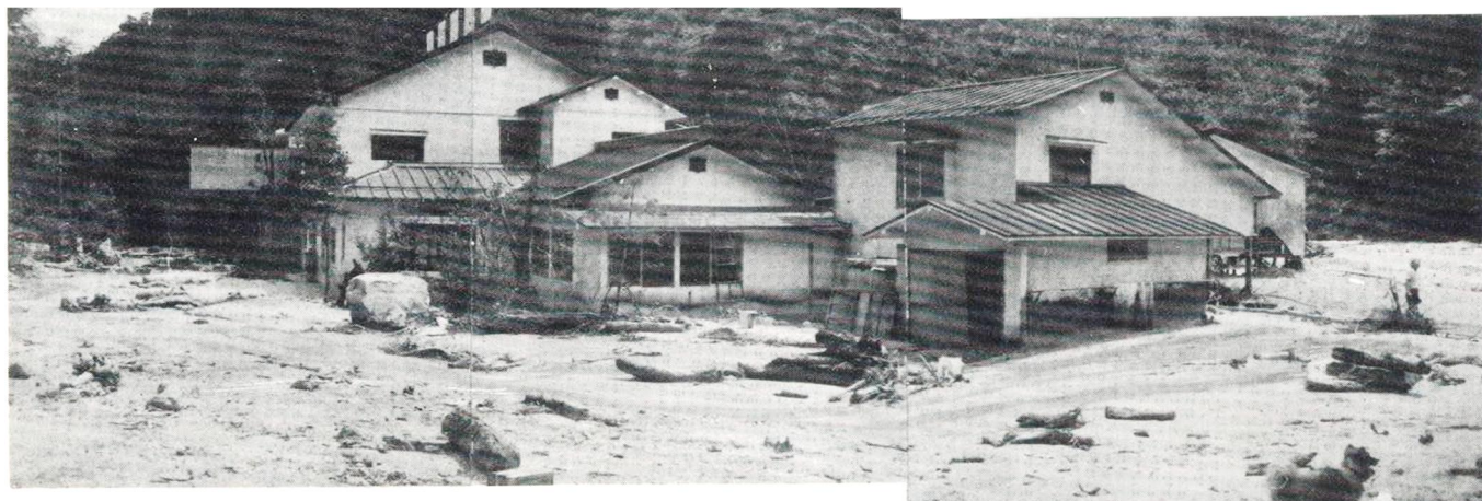
写真 4.18 濁流に見舞われた葛温泉仙人閣 （松本砂防工事事務所，1971）
