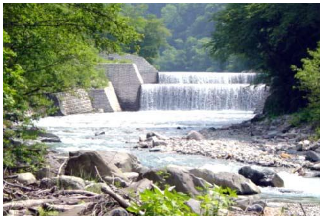
写真 5.7 ① 鹿島川 大町市平 猫鼻砂防堰堤 (松本砂防事務所) (松本砂防事務所 HP)
