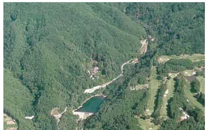
写真 5.18 ⑥ 牛伏川 松本市内田 牛伏寺砂防ダム（長野県） （長野県松本建設事務所，1999）
