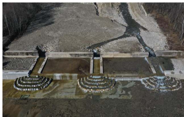
写真 5.12 ⑥ 簗川 大町市平 簗川第2号床固工 (魚道の設置) (松本砂防事務所) (松本砂防事務所, 2024 b)
