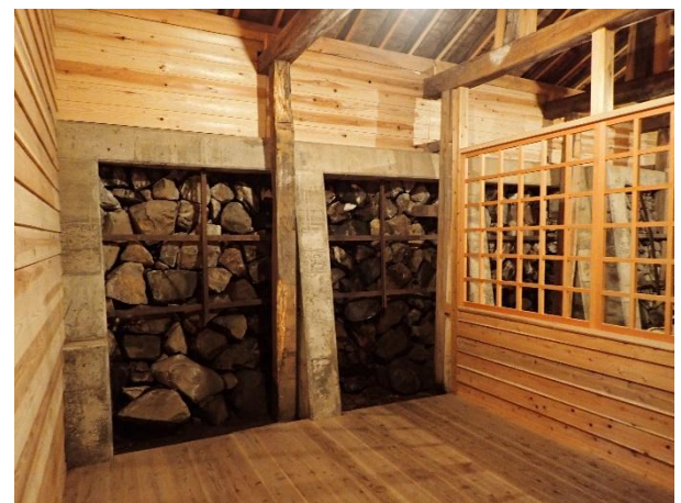
写真 1.8 見学用風穴の内部と冷風が吹き出す崖錐堆積物, 2024 年撮影
