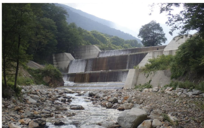
写真 5.11 ⑤ 簗川 大町市平 簗川第1号砂防堰堤 (松本砂防事務所) (松本砂防事務所, 2024 b)
