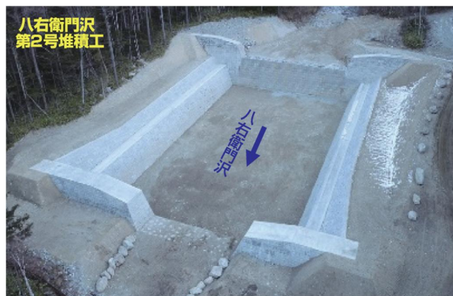
写真 5.8 ② 八右衛門沢 松本市安曇 八右衛門沢第2号堆積工 (松本砂防事務所) (松本砂防事務所, 2024 b)
