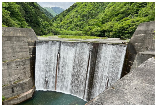
写真 5.10 ④ 島々谷川 松本市安曇 島々谷第3号砂防堰堤 (松本砂防事務所) (2024 年撮影)
