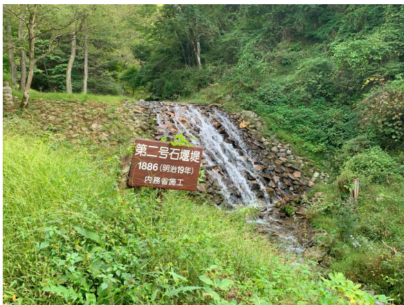
写真 5.15 ③ 牛伏川 松本市内田 牛伏川第二号堰堤（登録有形文化財）（長野県） （2024 年撮影）
