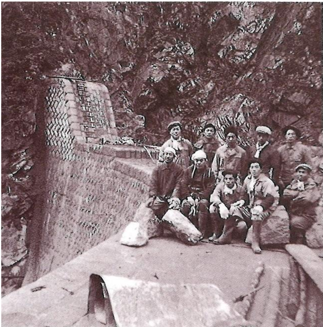
写真 5.6 山ノ神砂防堰堤の完成写真
