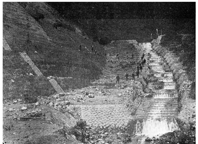
写真 5.2 牛伏川階段工 （牛伏川砂防工事沿革史編纂会、1933） 大正5年（1916）長野県施工 重要文化財
