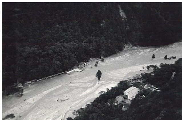
写真 4.16 葛温泉付近 （松本砂防工事事務所，1969）
