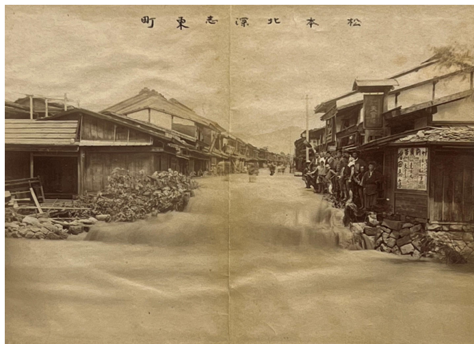
写真3.7 明治29年災害の被災状況写真 松本町北深志東町（松本市立博物館蔵）
