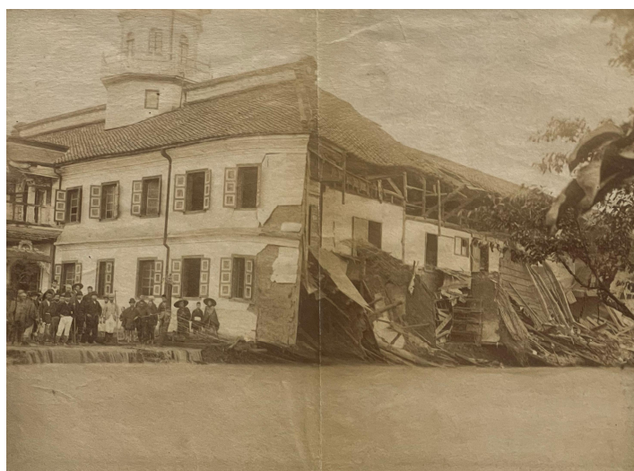
写真3.8 明治29年災害の被災状況写真 開智学校の破損状況（松本市立博物館蔵）
