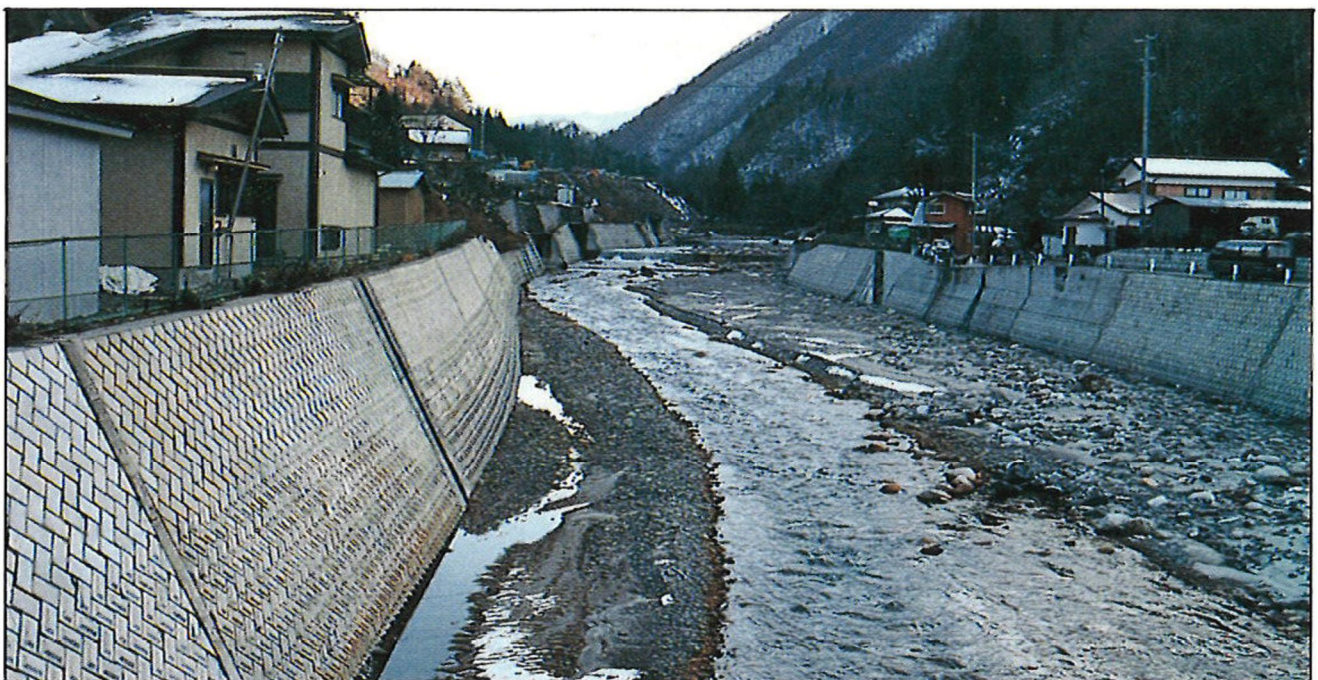
写真 2.44 下流への被害を著しく軽減した黒川渡流路工 （松本砂防工事事務所, 1984）
