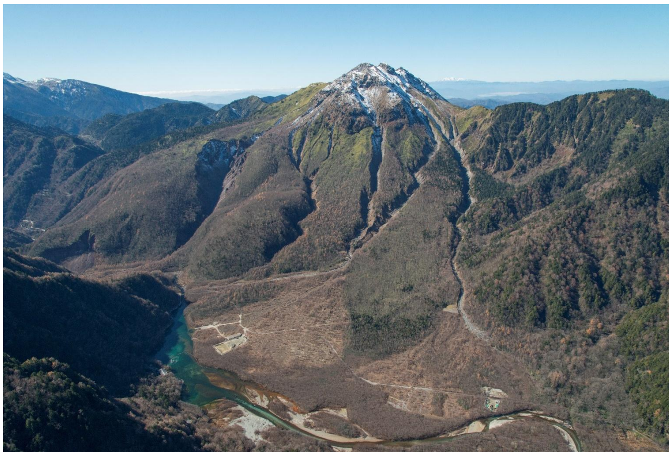
写真 2.16 焼岳・大正池付近の斜め航空写真, 2015 年松本砂防事務所撮影
