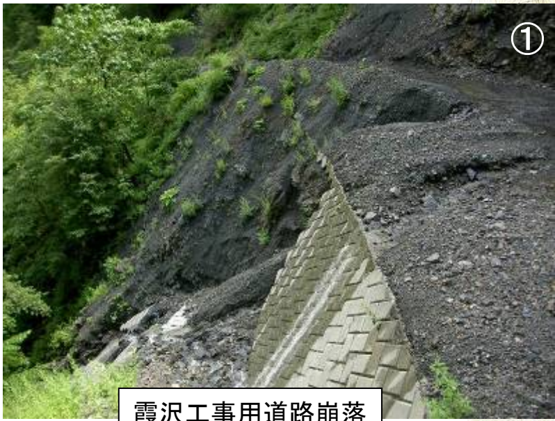
霞沢工事用道路法面崩落
