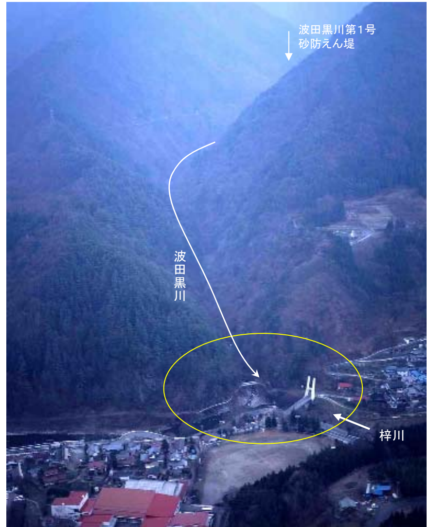
保全対象(橋場地区)
