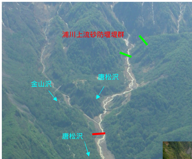
浦川上流砂防堰堤群全景
