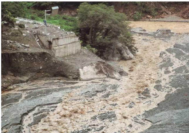
写真 2.47 土石流により流出した新国界橋 (蒲原沢) (長野県土木部, 1995 b)
