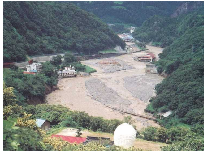
写真 2.40 被災後の姫川温泉 (新潟県土木部河川課・糸魚川土木事務所, 1996)
