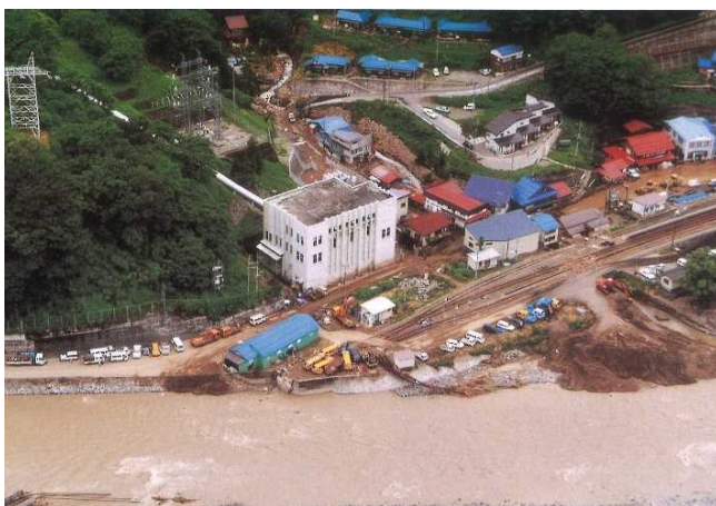
写真 2.49 土砂で半分埋まった中土駅 (長野県土木部, 1995 b)
