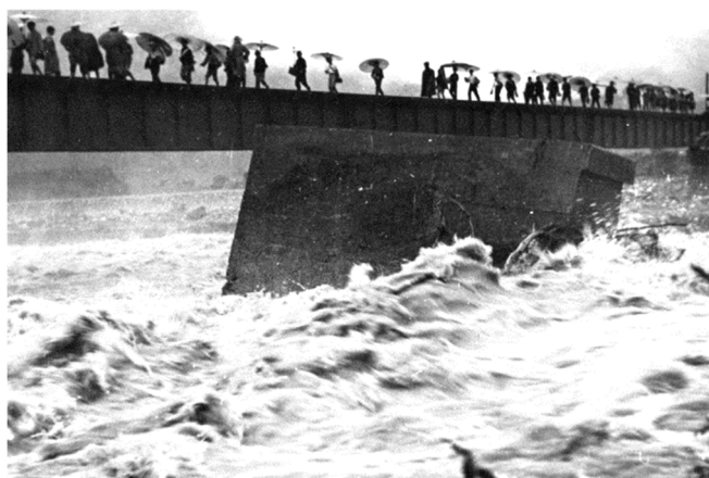
写真 2.37 松川橋（現国道 148 号）流失により 国鉄鉄橋を利用 （白馬村役場建設課，2001）
