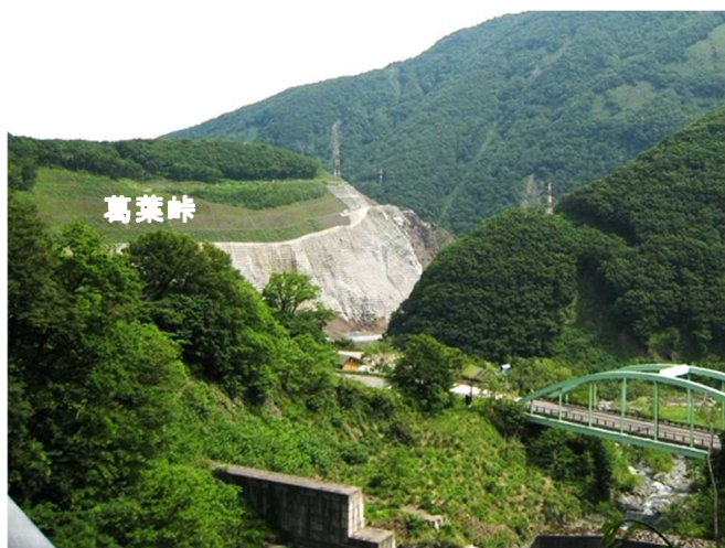
写真 2.6 対策工事後，2011 年森撮影 （新々国界橋は 1998 年に再建された）
