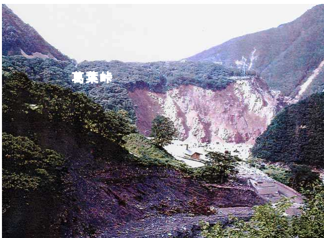
写真 2.5 真那板山大崩壊による河道閉塞堆積物， 1997 年撮影 （新国界橋は流失している）
