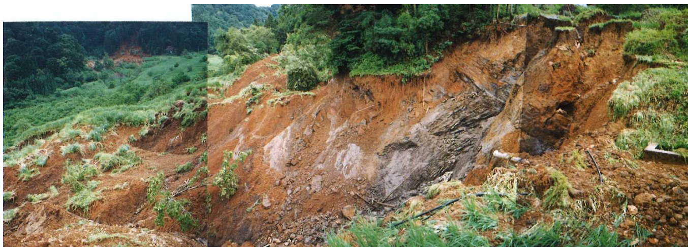
写真2.3 平成7年（1995）清水山地すべり斜面状況（Iブロック）
