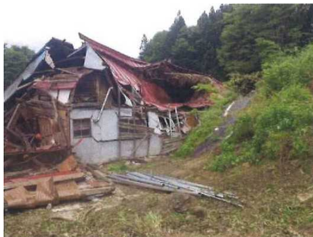
写真2.55 土砂によって潰された民家 （地盤工学会・土木学会地盤工学委員会，2014）
