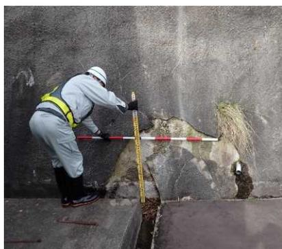
【既存モルタル吹付工の剥離・亀裂の状況】
