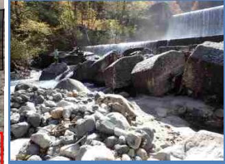
経年劣化による既設砂防設備の損傷・劣化状況
