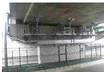
（落橋防止対策）
