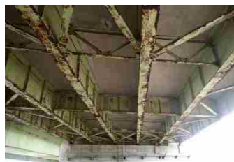
（鋼部材の塗装劣化）
