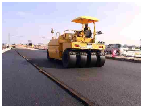
▲ 舗装工事実施状況
