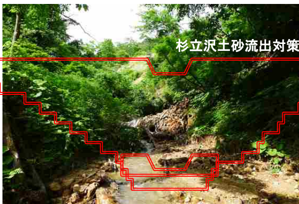
砂防堰堤の計画箇所
