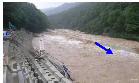
H25年9月 台風18号による出水の状況 (中津川上流溪流保全工)
