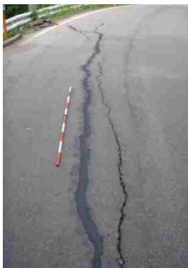
県道折戸飯田線 被害状況
