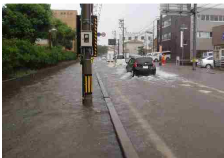
冠水発生状況
