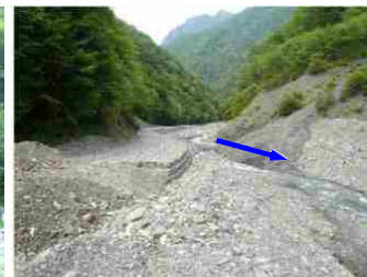
河床の堆積土砂
