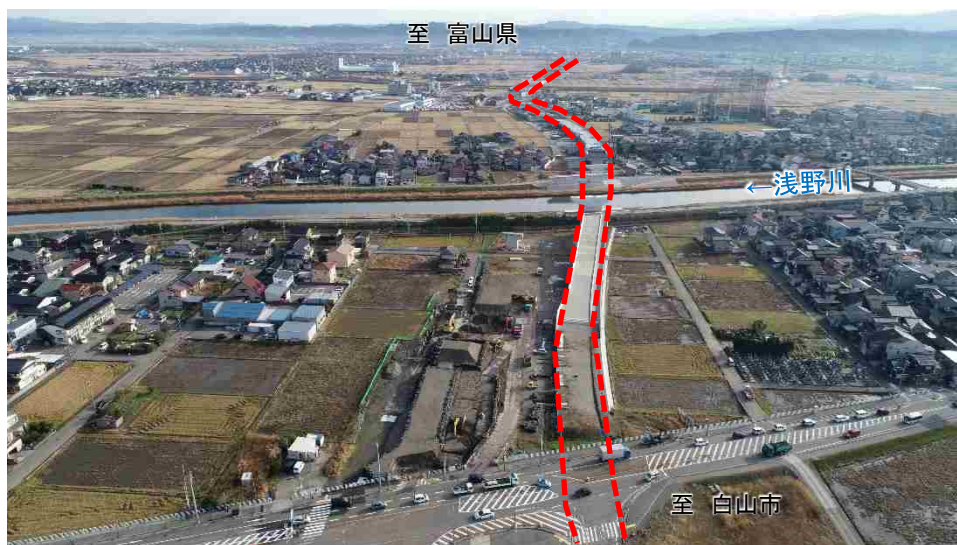
あきのがわ 施工状況（浅野川 周辺）
