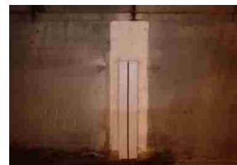
（対策イメージ： 断面修復・漏水対策）
