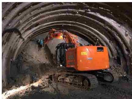
▲ 月浦トンネル施工状況
