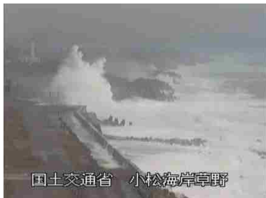
冬季風浪状況(小松工区:平成27年12月)
