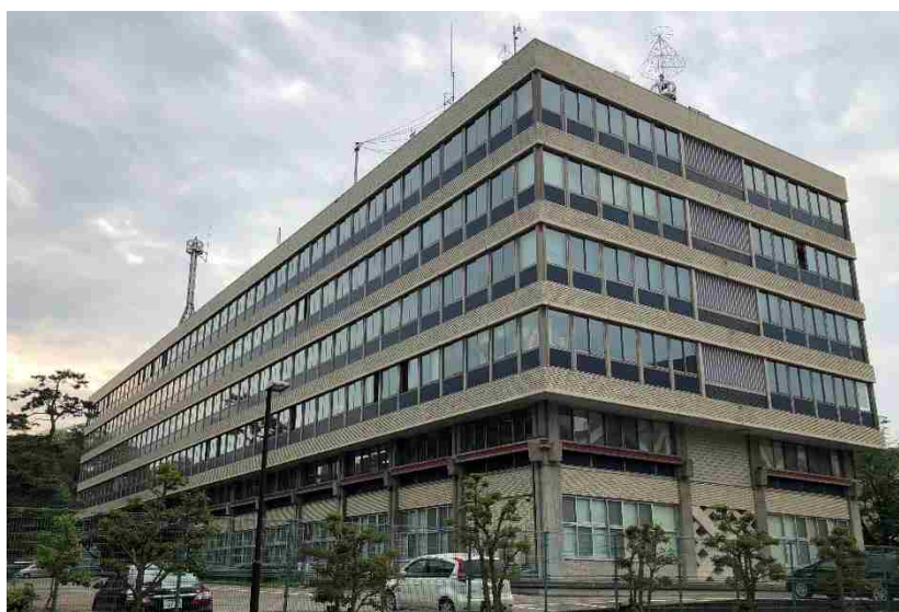
【金沢広坂合同庁舎外観写真】
