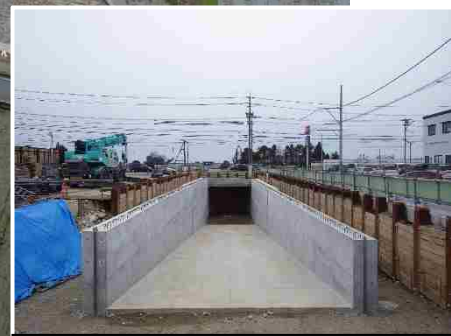
▲上野地区横断ボックス施工状況
