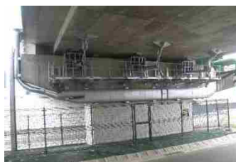
（落橋防止対策）
