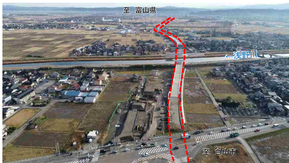
あさのがわ 施工状況（浅野川 周辺）
