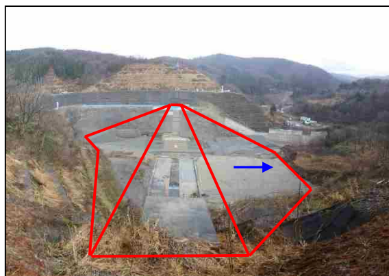
ダム本体施工状況（令和元年12月撮影）
