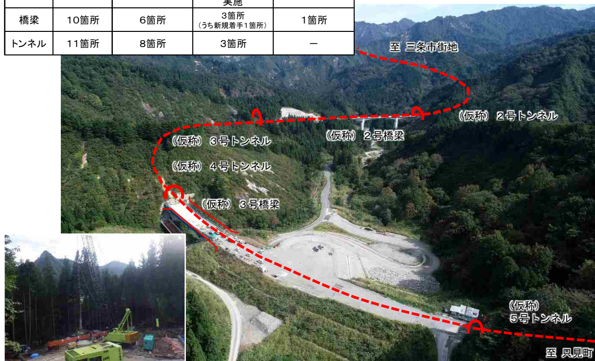
▲ 地すべり対策施工状況
