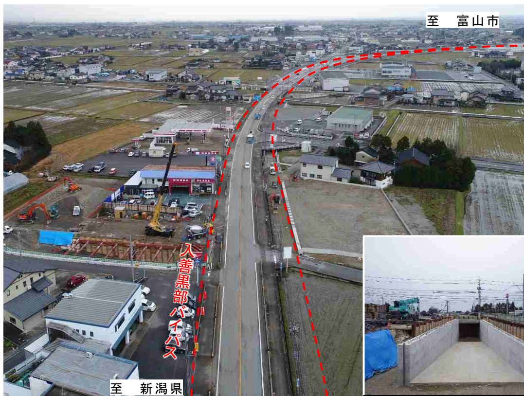
▲上野地区横断ボックス施工状況
