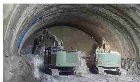
▲ 1号トンネルの施工状況 約8割掘削(約790m/1,007m) 脆弱な地山のため慎重に工事を推進
