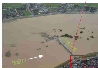
◀【写真左】出水時の こすど 小須戸橋
