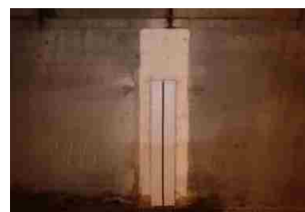
（対策イメージ： 断面修復・漏水対策）
