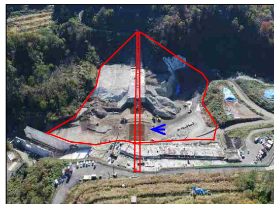
航空写真（左岸よりダムサイトを臨む 令和元年11月撮影）
