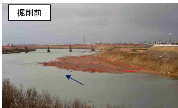
(土砂掘削のイメージ)
