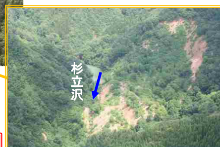
上流の大規模崩壊地
