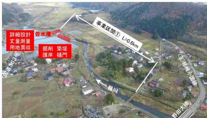
未改修区間（事業区間①）の状況
