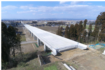
▲ H31.1末に完成した伊加流伎大橋
