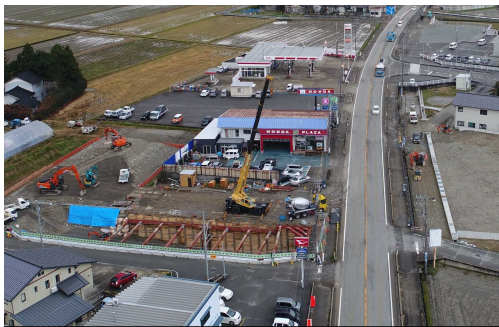
▲ 町道横断ボックスの施工状況
