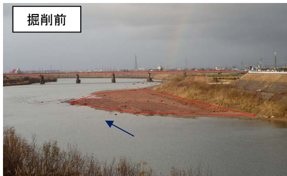
(土砂掘削のイメージ)
