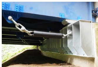
（落橋防止対策）
