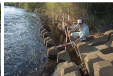
河道状況の確認
