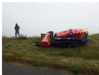
大型遠隔式除草機械による除草
