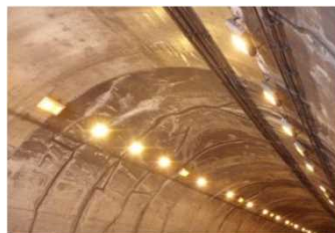
（覆エコンクリートのひび割れ）
