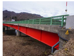
（修繕：塗装塗替）
