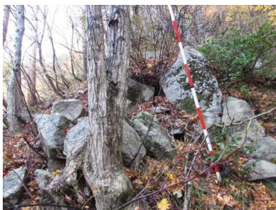
法面の岩塊状況
