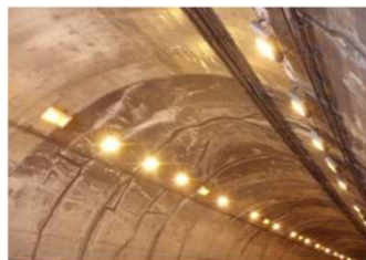
（覆工コンクリートのひび割れ）
