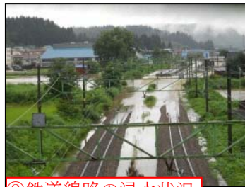
②鉄道線路の浸水状況
