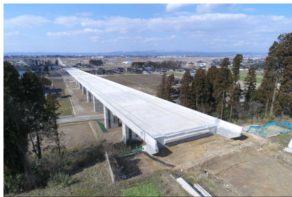
▲ H31.1末に完成した伊加流伎大橋
