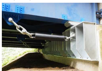
（落橋防止対策）
