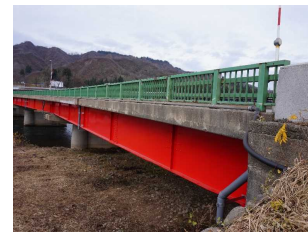
（修繕：塗装塗替）
