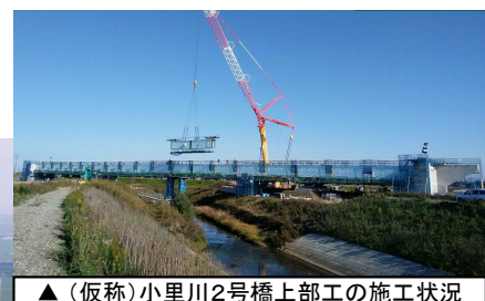
▲（仮称）小里川2号橋上部工の施工状況
