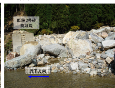
既設堰堤の堆砂状況
