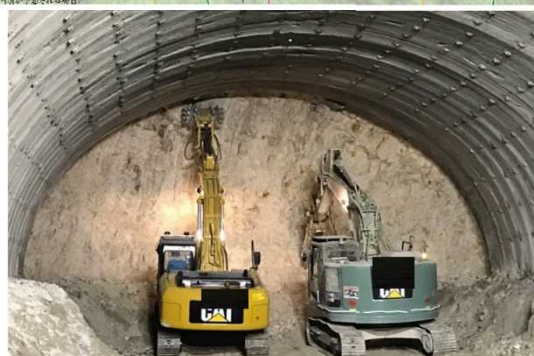
▲(仮称)1号トンネルの掘削状況
