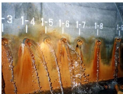
袖の沢地区 集水ボーリング
