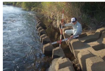
河道状況の確認
