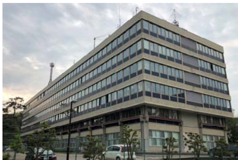
【金沢広坂合同庁舎外観写真】
