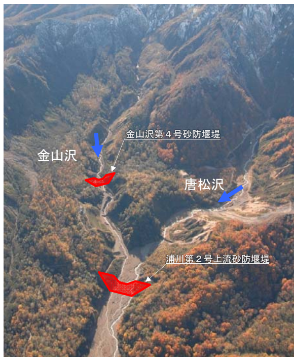
浦川上流砂防堰堤群全景
