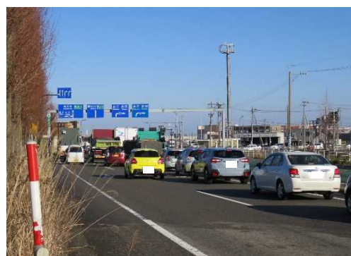
国道157号 乾東交差点（石川県 白山市）
