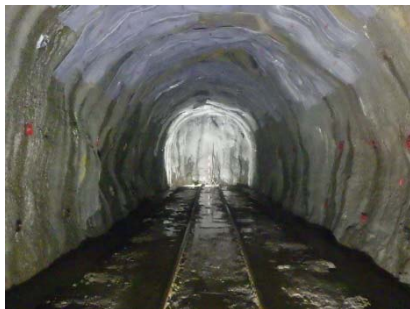
大石西山地区 排水トンネル
