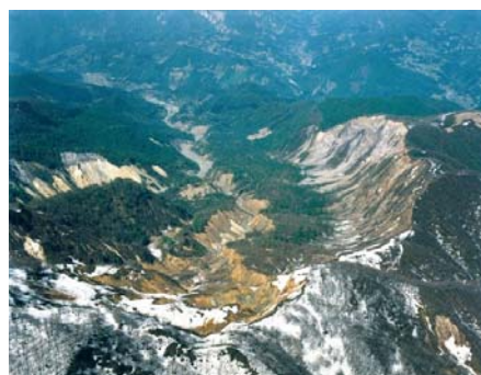
浦川上流にある稗田山崩壊地
