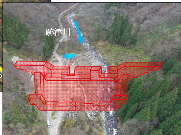
跡津川上流砂防堰堤
