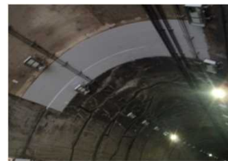
（修繕：剥離・剥落対策）
