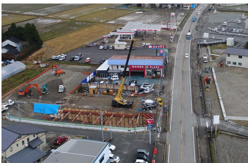
▲ 町道横断ボックスの施工状況
