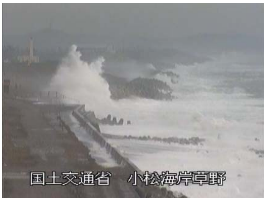
冬季風浪状況(小松工区:平成27年12月)
