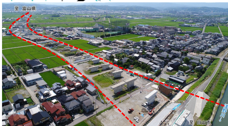
浅野川付近の施工状況
