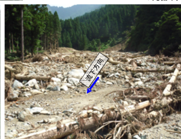
既設床固の状況
