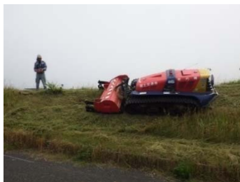
大型遠隔式除草機械による除草
