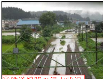
②鉄道線路の浸水状況
