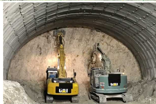
▲(仮称)1号トンネルの掘削状況
