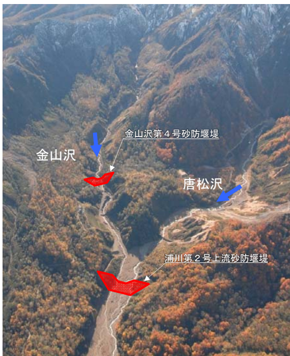
浦川上流砂防堰堤群全景
