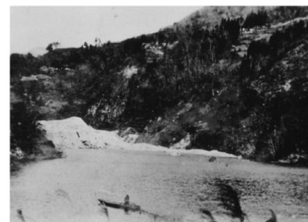
明治44年8月 稗田山大崩壊形成された天然ダム
