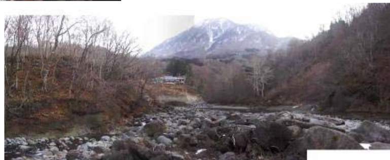
中津川上流第1号砂防堰堤計画地
