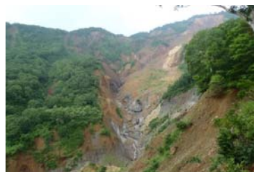
金山沢 源頭部の荒廃状況
