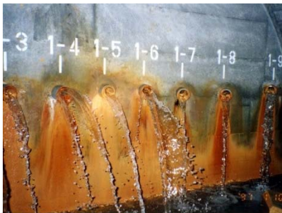
袖の沢地区 集水ボーリング
