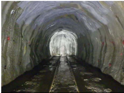
大石西山地区 排水トンネル
