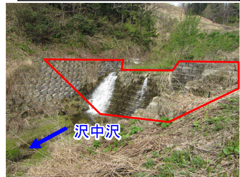
さわなかざわ 沢中沢砂防堰堤 改築（部材製作）
