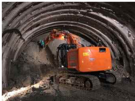
▲（仮称）月浦トンネル施工状況
