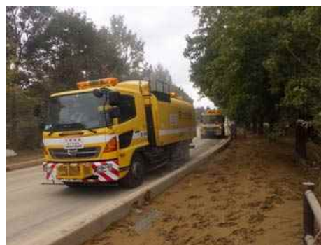
路面清掃車による堆積土砂撤去状況
