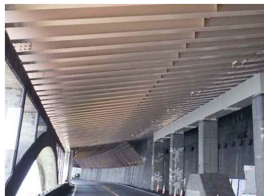
( 補修：塗装塗替 )
