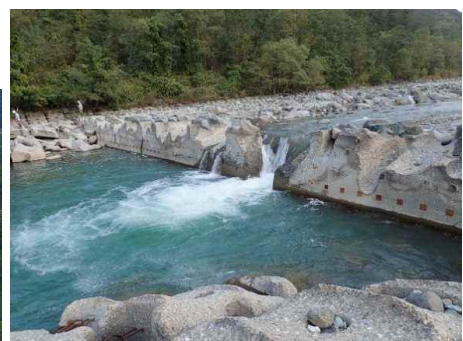
既存設備(床固工)の損傷状況
