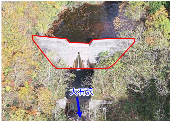
おおいざわ 大石沢砂防堰堤 改築（腹付け）
