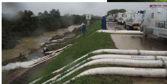
排水ポンプ車・照明車による復旧活動状況
