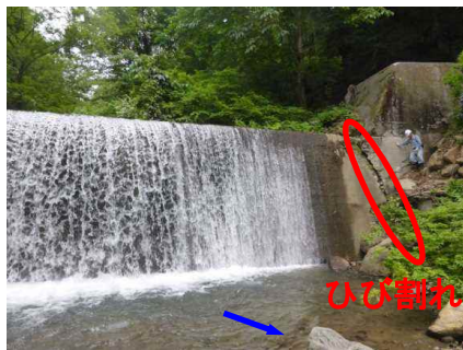
既設砂防堰堤（小赤沢）の損傷状況
