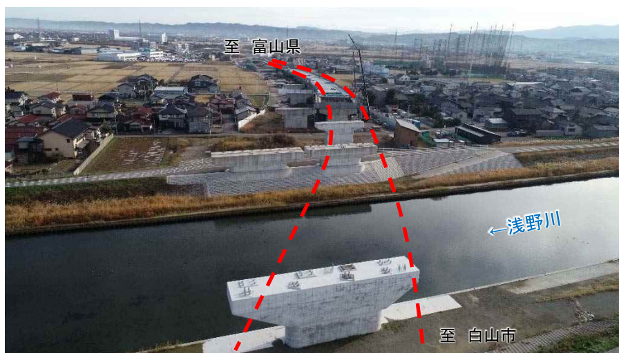
施工状況（ あさのがわ 浅野川 周辺）
