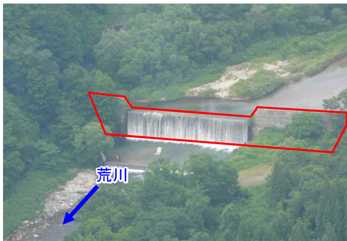
とくあみ 徳網砂防堰堤 改築（腹付け及び嵩上げ）
