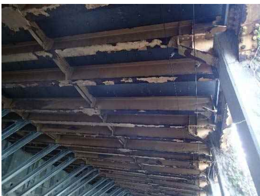
( 鋼部材の腐食及び塗装劣化 )
