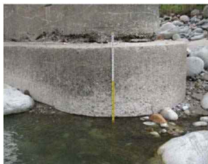
損傷状況 河床洗掘
