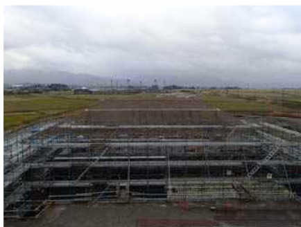
▲月崎地区周辺の施工状況
