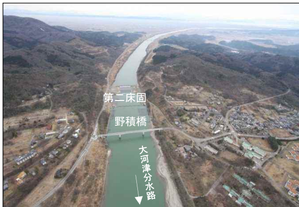
流下断面が不足し、抜本的な改修が必要な大河津分水路
