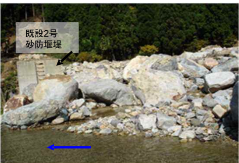
既設砂防堰堤の異常堆砂状況
