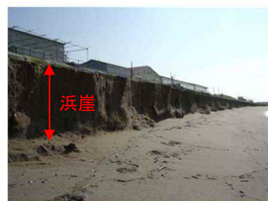
金衛町工区被災状況(平成18年9月)
