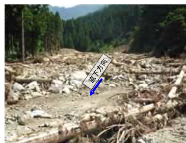
既設床固の状況
