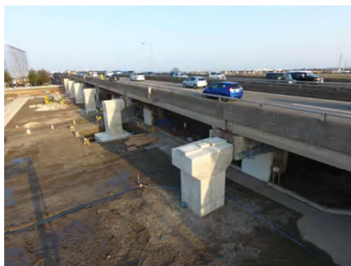
▲ 新屋地区の施工状況
