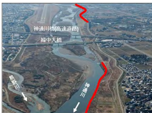
左岸10.2km付近を下流より望む
