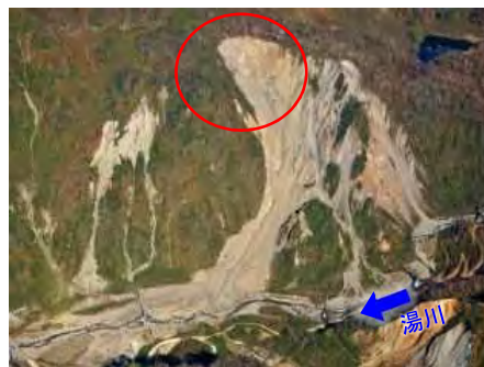
H23. 6攝影(崩壞後)
