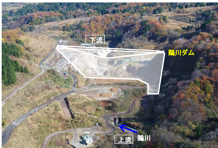
航空写真（上流よりダムサイトを望む 平成29年11月撮影）
