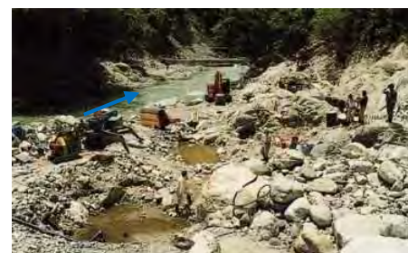
H7年 黒薙温泉源泉被災状況
