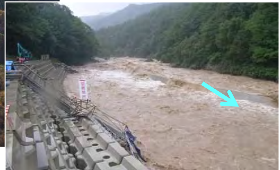
平成25年9月 台風18号出水の状況 （中津川上流溪流保全工）
