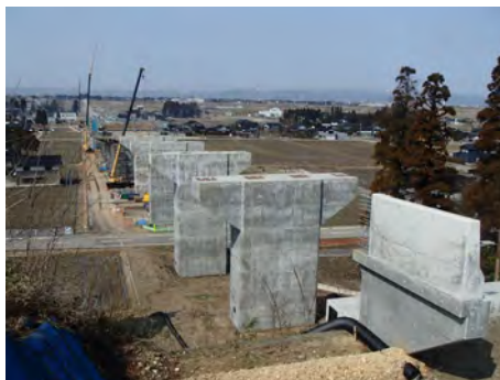
▲ 頼成地区の施工状況
