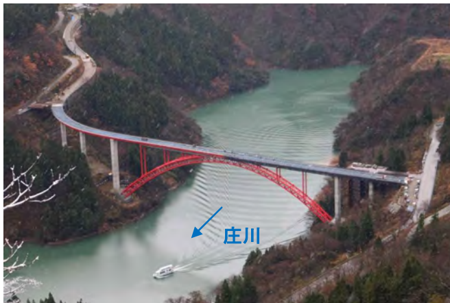
庄川橋梁上部工 工事状況 (平成29年12月撮影)
