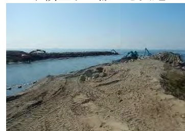
堆積土砂撤去状況
