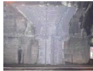
（修繕：断面修復）
