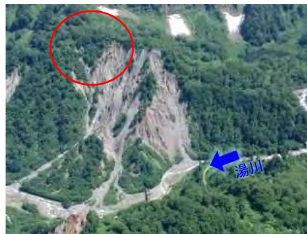
H23. 6撮影(崩壊前)
