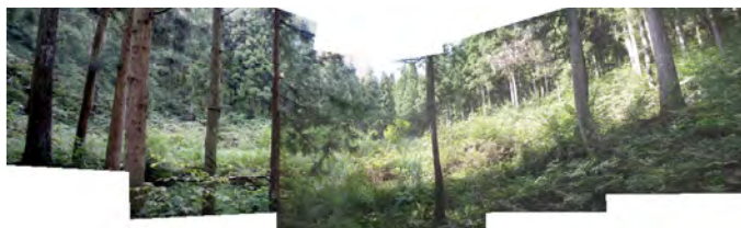
穴沢第2号砂防堰堤 施工箇所
