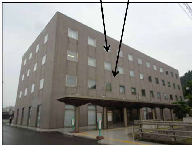
【庁舎外観写真】
