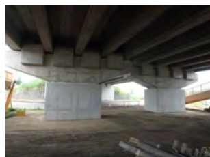
（橋脚補強対策）
