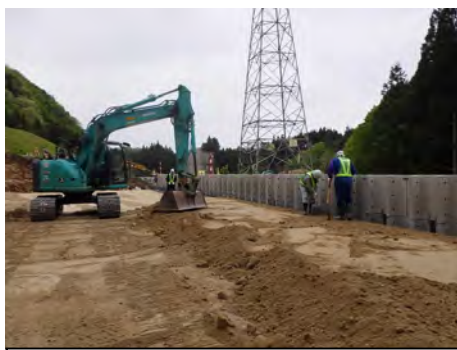
▲ 大須戸地区の施工状況
