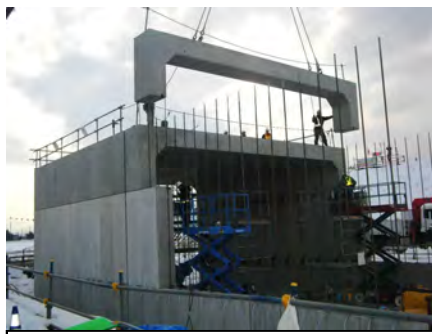
▲ 下野田地区の施工状況
