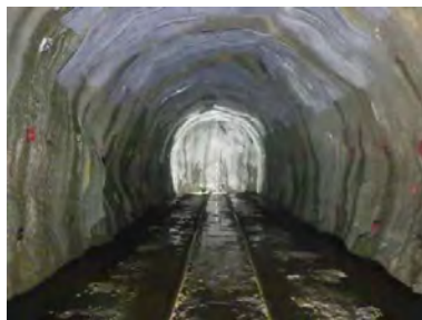
大石西山地区 排水トンネル
