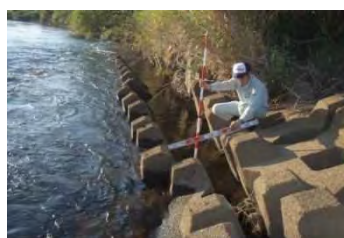
河道状況の確認
