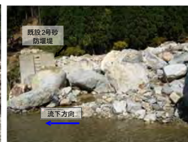
既設堰堤の堆砂状況
