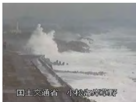
冬季風浪状況(小松工区:平成27年12月)
