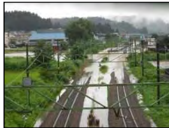
②鉄道線路の浸水状況
