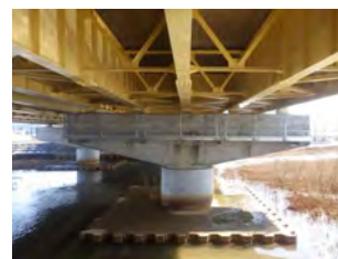
（修繕：塗装塗替）
