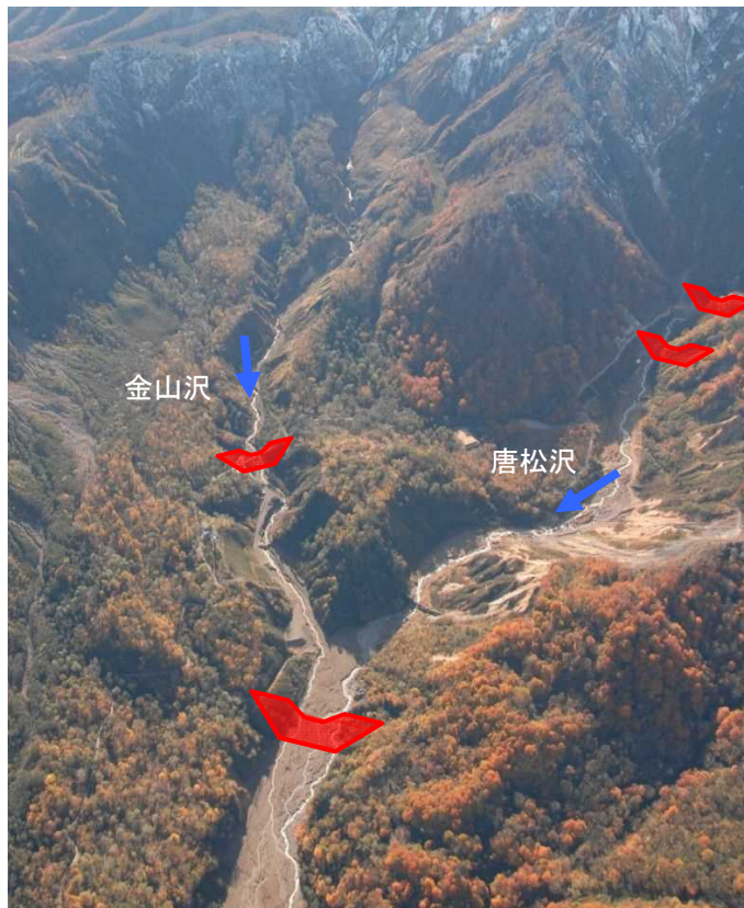
浦川上流砂防堰堤群全景
