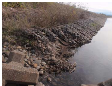
欠損した河岸に根固めブロックを設置し保護
