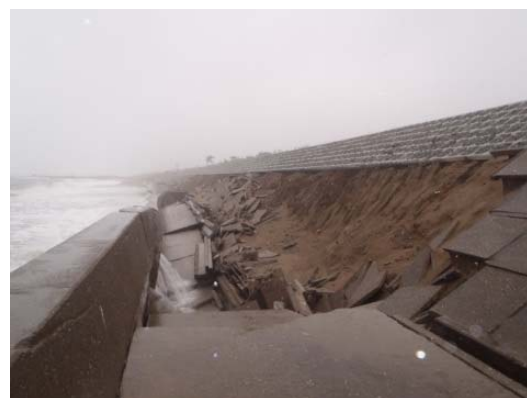
施設被災状況(小松市安宅地先:平成24年12月)
