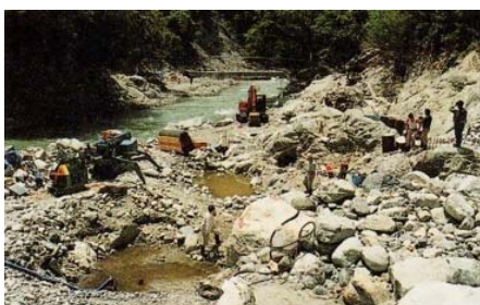
H7年 黒薙温泉泉源被災状況
