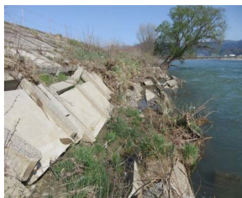
洪水で破損した護岸を補修し、機能を回復
