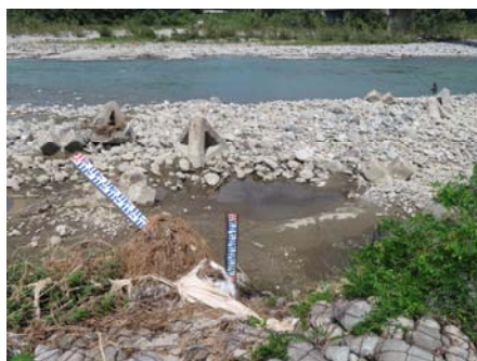
洪水時に流失・破損した観測施設を補修し、機能の回復を図る
