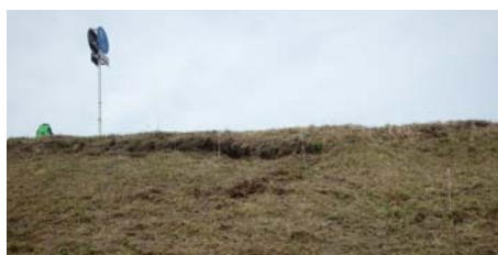
亀裂が発生した堤防法面を修繕
