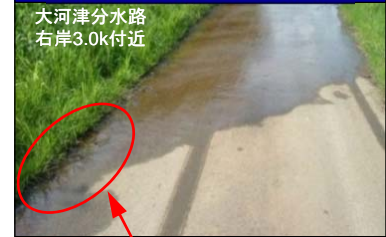
堤防川裏漏水状況(H18.7洪水時)
