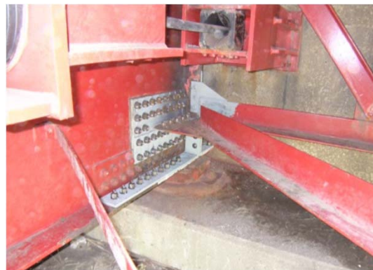
( 修繕：あて板による補修 )
