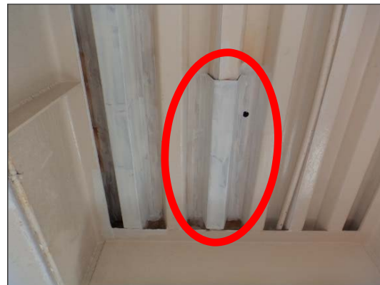
( 修繕：床版の当て板補修 )
