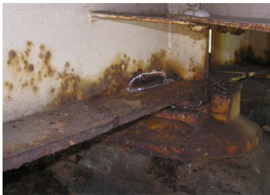
( 鋼部材の腐食 )
