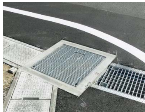
(対策イメージ : 側溝更新、舗装勾配修正)
