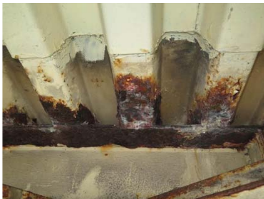
( 床版の板厚減少を伴う腐食 )
