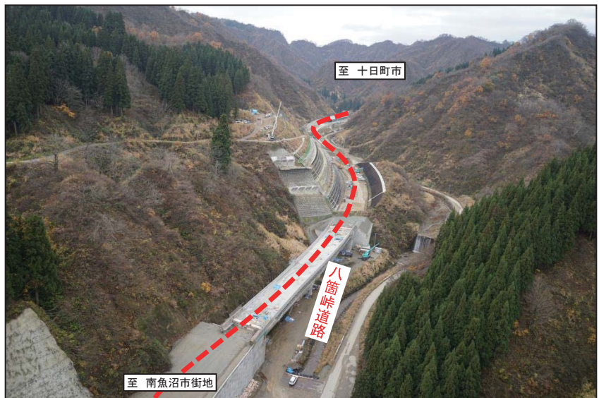
欠之上地区の施工状況
