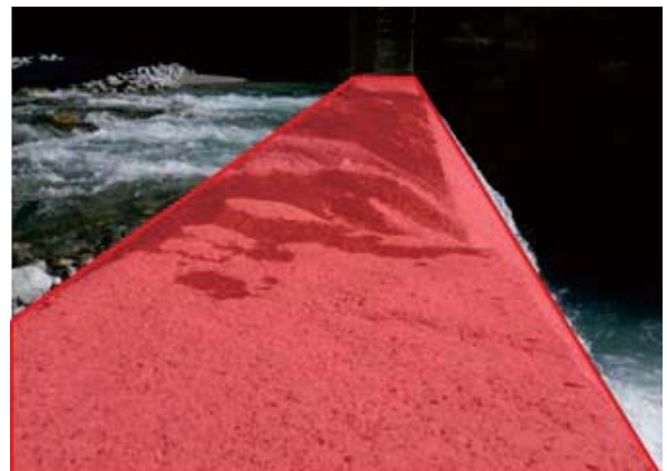
黒薙川第2号砂防堰堤
