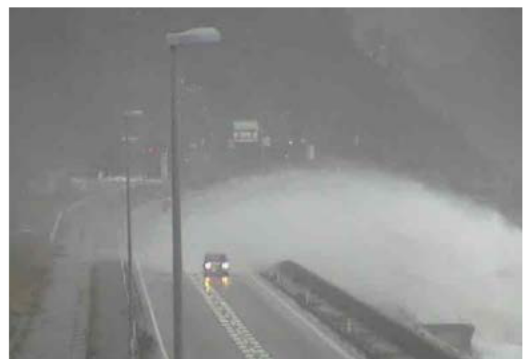
道路の越波対策
