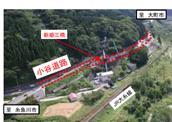
国道148号 小谷道路 (長野県)
