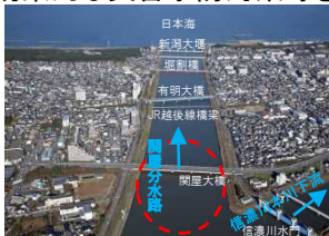
信濃川下流 関屋分水路地区 河川改修(新潟県)
