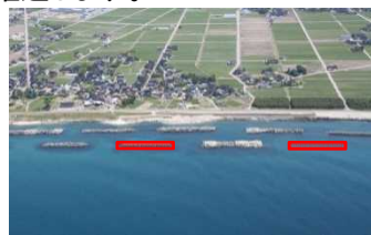
下新川海岸 第3工区:吉原地区 海岸保全施設整備(富山県)
