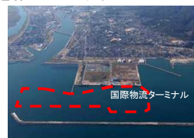
伏木富山港伏木地区
