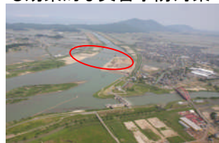
信濃川 大河津可動堰改築(新潟県)
