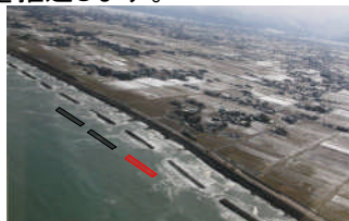
下新川海岸 海岸保全施設の整備(富山県)
