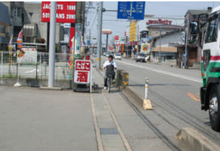
国道157号堀内・三日市自転車 歩行者道整備(石川県)
