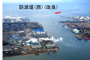
新潟港東港区防波堤改良事業 (新潟県)
