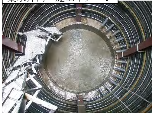
集水ボーリング 施工イメージ
