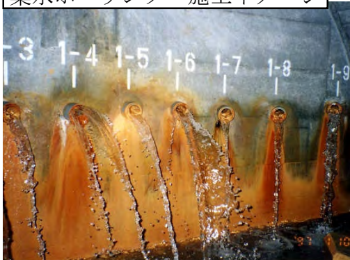
集水ボーリング 施工イメージ
