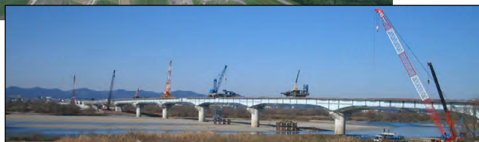
上部工が閉合した信濃川橋梁
