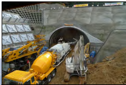
黒岩トンネル工事状況
