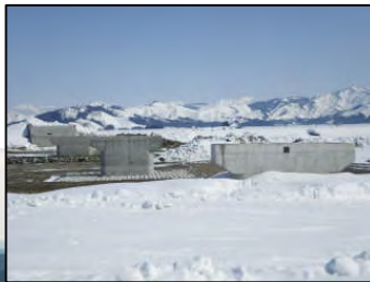
水無大橋施工状況
