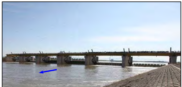
新堰通水後写真
