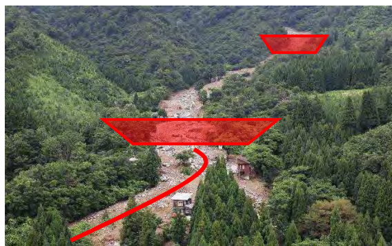
不安定土砂が堆積する堰堤計画位置（土沢）
