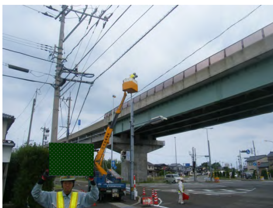
【点検イメージ】 道路照明灯具取付部の点検
