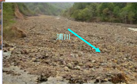
平成24年7月の土石流災害発生状況
