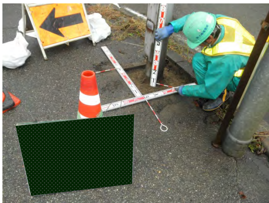
【点検イメージ】 道路標識柱脚部の点検
