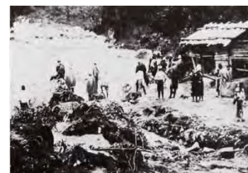
昭和9年手取川大水災害時の白峰村風嵐の様子 (推定1億m 3 を超える土砂が流出し河床が著しく上昇)
