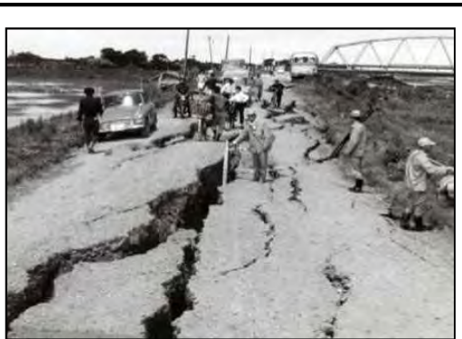
昭和39年 新潟地震による阿賀野川の堤防被害状況
