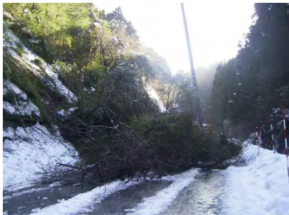
並行する国道160号の法面崩れによる被災状況(H23.1.1)
