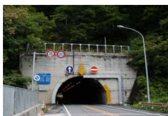
道路構造物(トンネル・橋梁等) の緊急修繕
