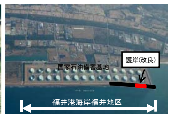
福井港海岸福井地区 海岸保全施設の整備推進(福井県)
