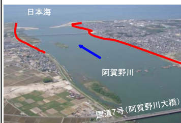
阿賀野川 堤防の耐震対策等の推進 (新潟県)
