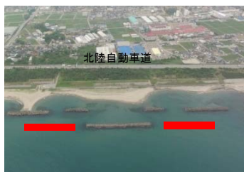
石川海岸 海岸保全施設の整備推進 (石川県)
