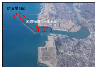
金沢港大野地区 国際物流ターミナル整備事業(石川県)
