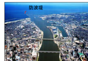
新潟港西港区 防波堤整備事業(新潟県)
