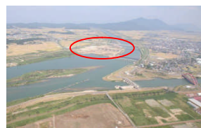
信濃川 大河津可動堰改築(新潟県)
