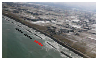
下新川海岸 海岸保全施設の整備(富山県)
