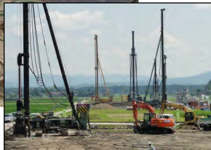
鶴町地区改良工施工状況
