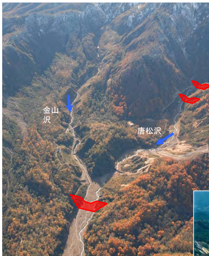
浦川上流砂防堰堤群全景
