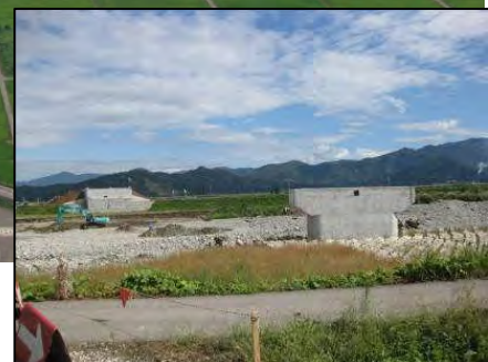
水無川橋(仮称)施工状況
